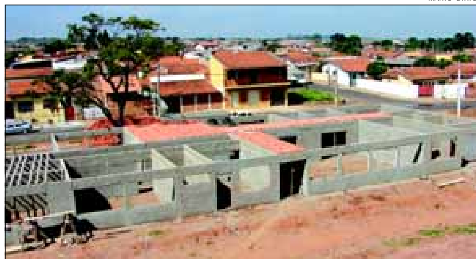
Construção da nova escola de educação infantil no bairro Santa Elizabeth prossegue em ritmo acelerado
