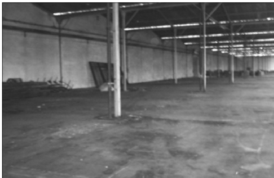
O Posto de recebimento e armazenamento de pneus inservíveis já está em pleno funcionamento no Galpão do antigo IBC
