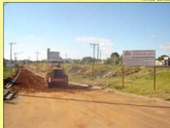
Com a pavimentação moradores do Jardim Paineiras evitarão passar pela rodovia
