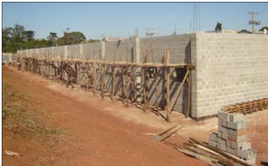
A Prefeitura fez a doação do terreno para a execução da obra
