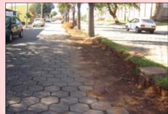
Local onde receberá o recape já está sendo preparado para a colocação de guias e sarjetas
