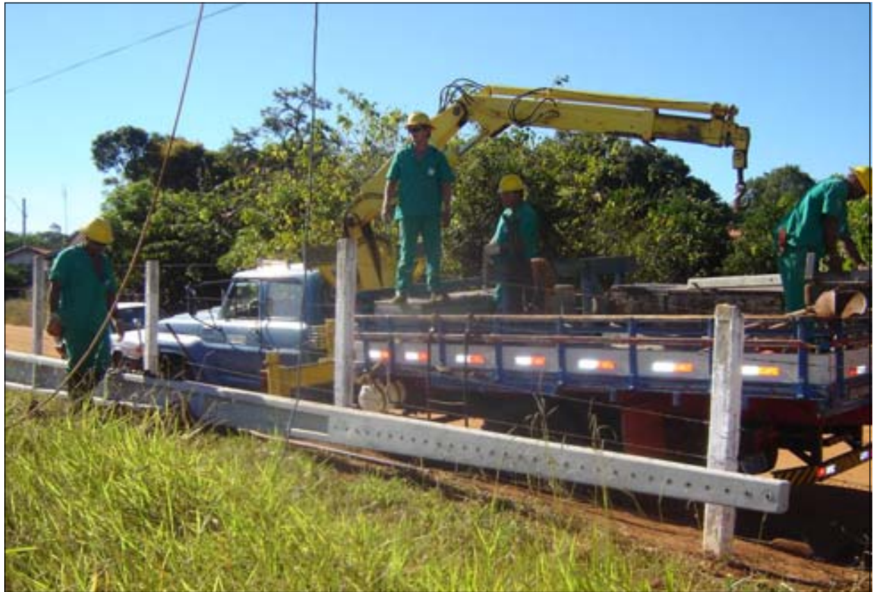
Nova iluminação garantirá mais segurança a moradores e visitantes
