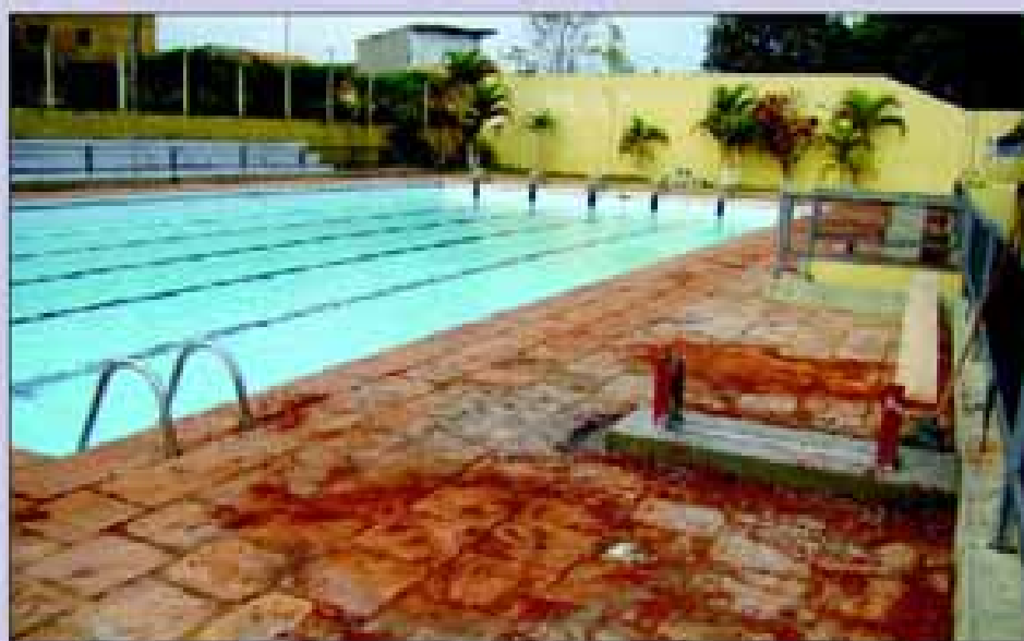
Início da construção da cobertura da piscina do C.E. "Kim Negrão"
