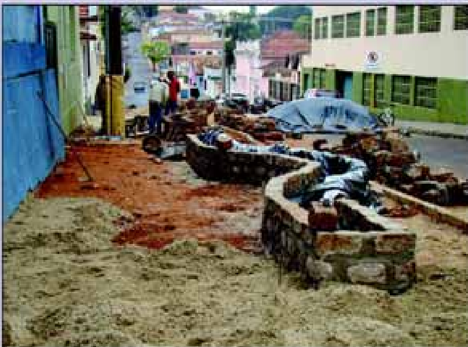
Implantação do calçadão da Rua Major Vitoriano
