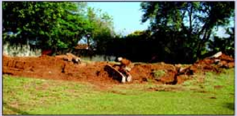
Preparação do terreno para construção da Escola "Licinia Guazzelli"
