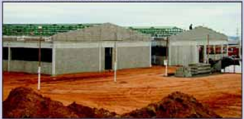
Aspecto das obras da Escola Técnica Federal
