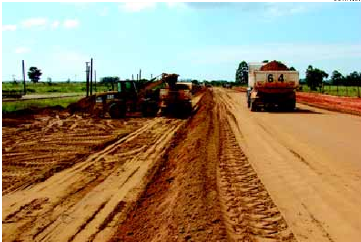
Obras de terraplanagem: trecho dos nove quilômetros a serem pavimentados
