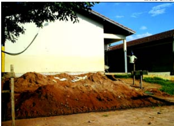
Construção de novos banheiros na escola
