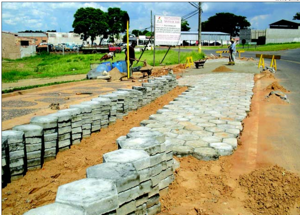
A obra melhorará o acesso de pedestres no local
