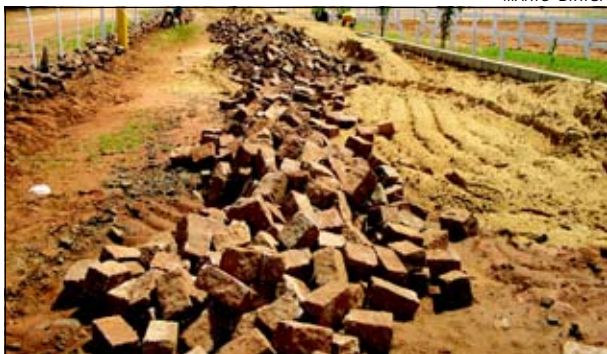
Paralelepípedo utilizado foi retirado das ruas do Bairro Alto
