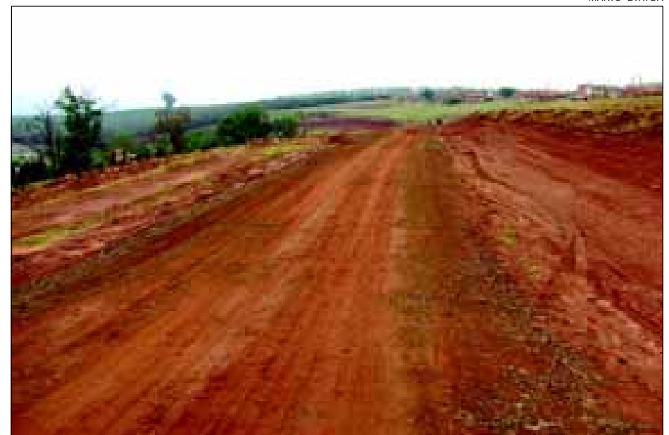
O encerramento dos trabalhos se deu com a finalização do último trecho, próximo a Vila Operaria
