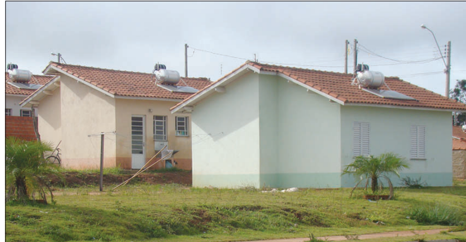
Casas com aquecedor solar no Bairro do Camargo
