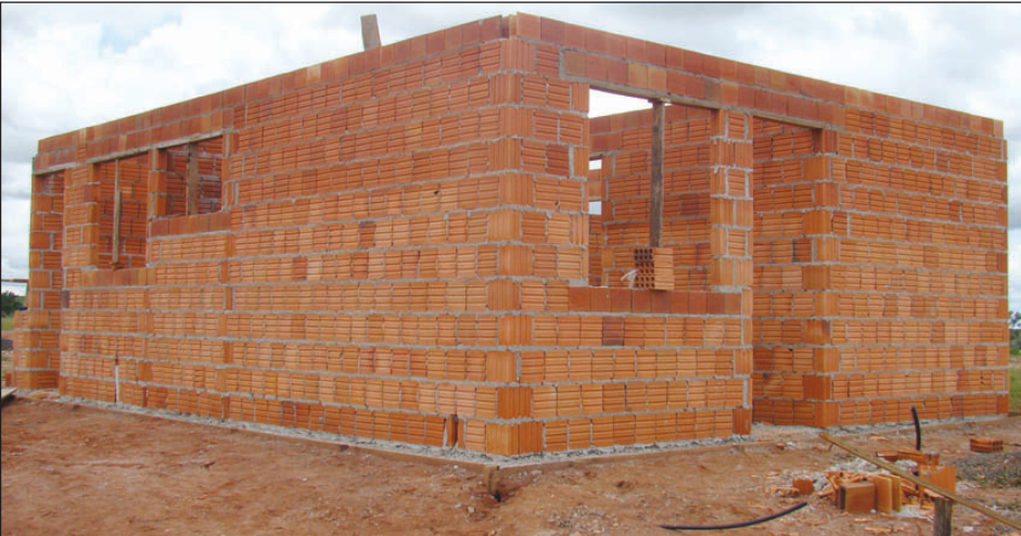
Início da construção das 22 casas da Barra Grande
