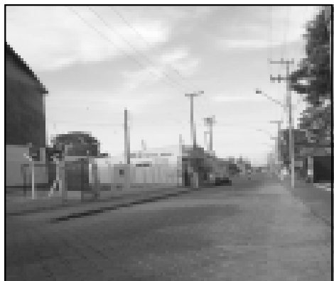
Rua Santos Dumont com a lombada já retirada
