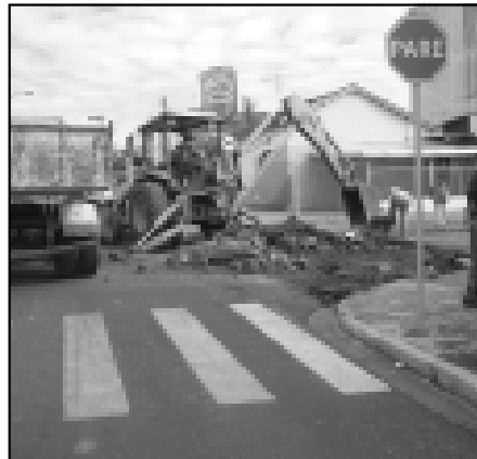
Retirada da lombada da Rua Bahia
