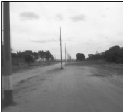
Neste ano a Prefeitura recuperou a Avenida retirando os entulhos e melhorando a iluminação
