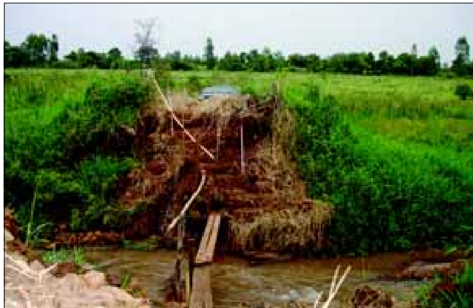
A destruição da ponte foi provocada pelas grandes chuvas
