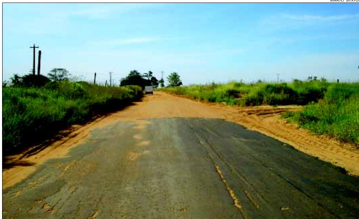
No total serão 18,5 quilômetros de pavimentação e recape
