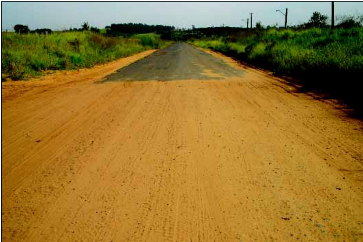
No total serão 18,5 quilômetros de pavimentação e recape
