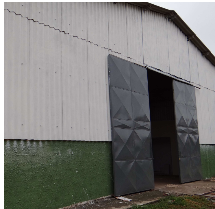
Barracão recebeu reforma e pintura
